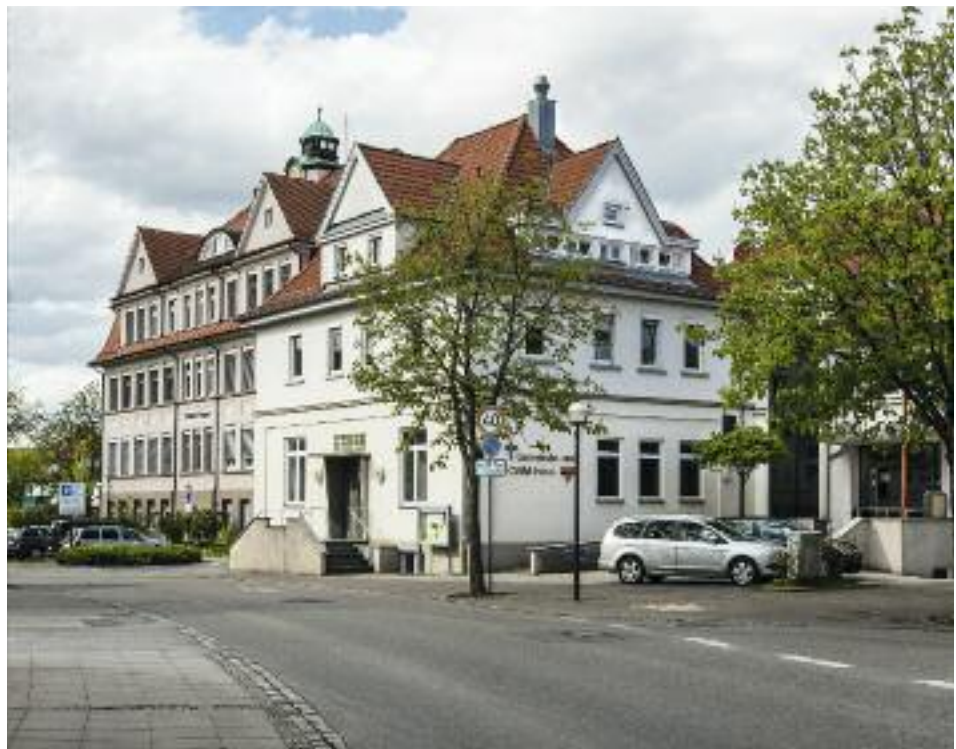
Das Gemeinde- und CVJM-Haus wird – wesentlich im Inneren – dieses Jahr noch eine kostenintensive Baustelle
