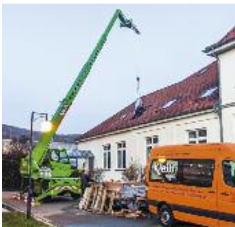
Einbau der neuen Dachflächenfenster
